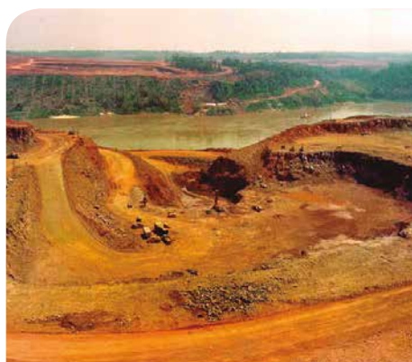
Terraplanagem da obra
