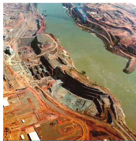
Vista aérea da obra
